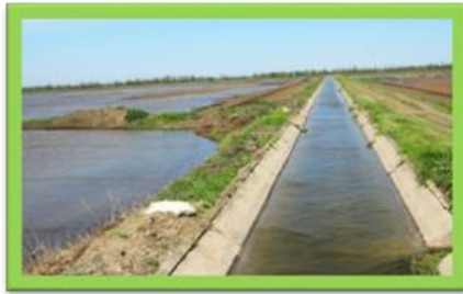
Рис. 9. Подача води на чеки
