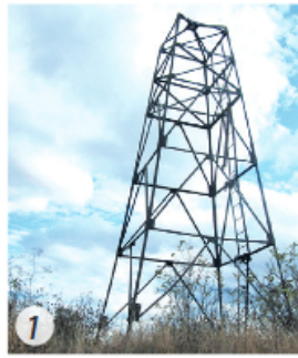
Опорний пункт державної геодезичної мережі (1). Репер – знак абсолютної висоти точки (2)
